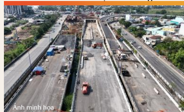
Hầm chui HC1-02 dự kiến thông xe
